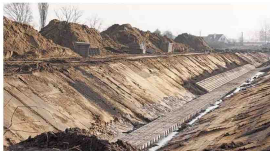
De realisatie van het bedrijventerrein Haandeput, gesitueerd tussen Tielstraat en Marialoopsteenweg, geraakt stilaan in een stroomversnelling. N-VA eist een betere opvolging van de werken om de last voor de omwonenden te beperken. (Foto dede)
